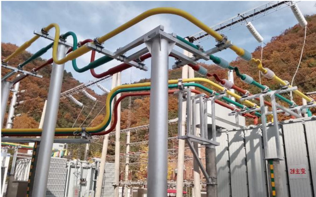
(交联聚乙烯固体绝缘管型母线)
